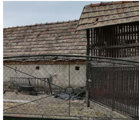
Gazdálkodáshoz, portahasználathoz kapcsolódó melléképület, góré,
